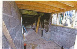
SENKET GARD Linder påbeveget, rede i kjelleren, har det kommet ny mur enkelte steder, og gulvet er senket. Her skal det bli vaskerom.
