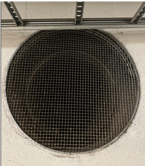
Figur 6 Uklassifisert avtrekksvifte og åpen glippe over dør til rom Teknisk garasje A.U.05
