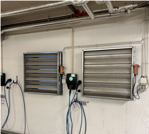
Figur 4 Uklassifiserte ventilasjonsrister for luftinntak ved sykkelparkering akse B-F
