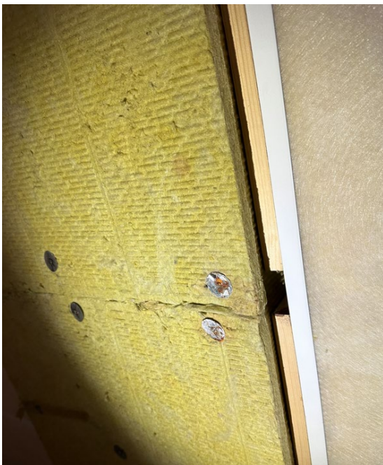
Figur 8 Synlig treverk ved hattebjelke av stål
