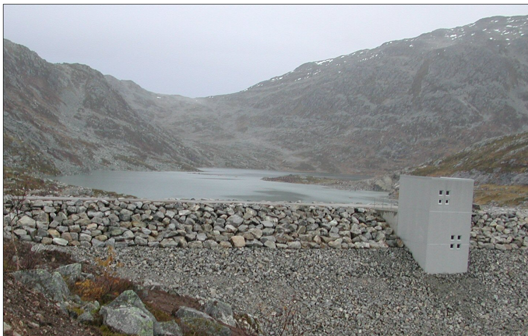
Figur 10: Damanlegget ved Øvre Langvatn.
