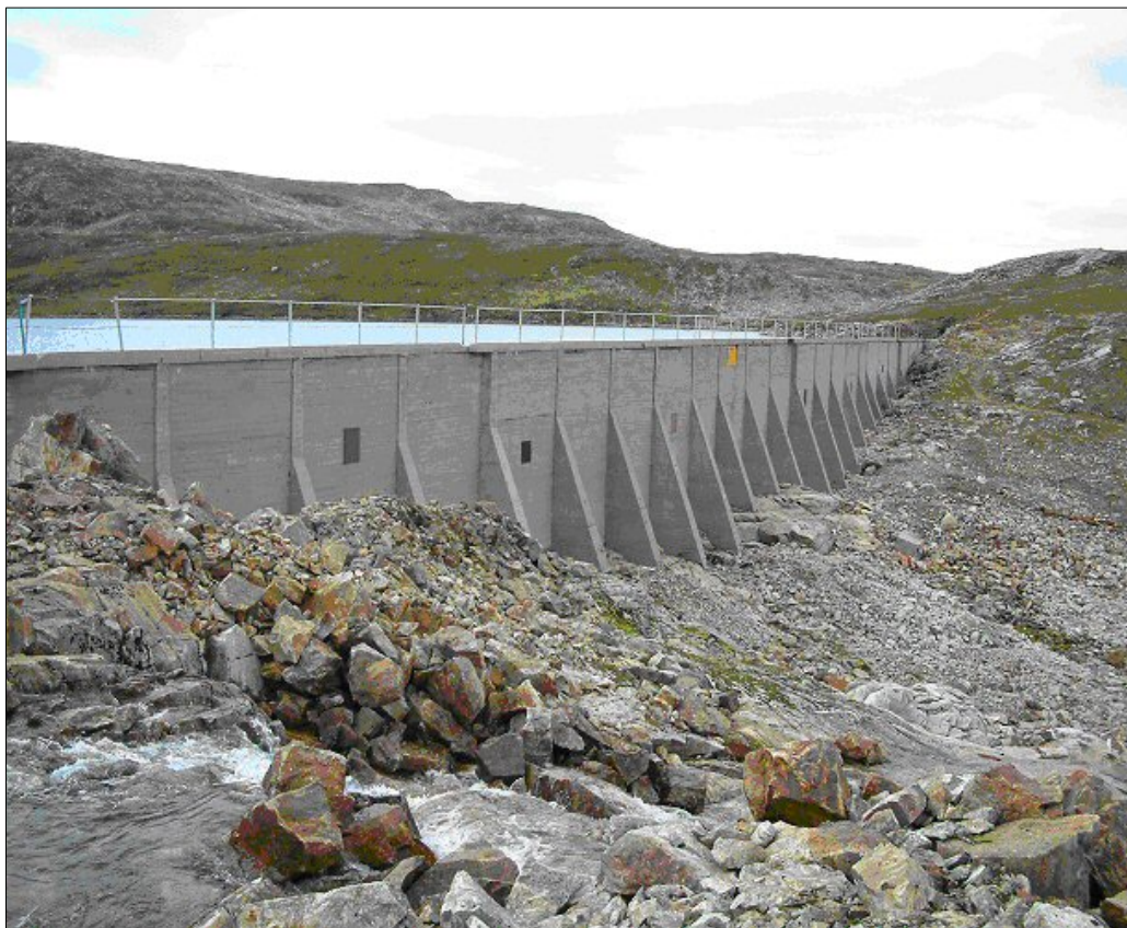
Figur 9: Damanlegget ved Amundvatnet.
